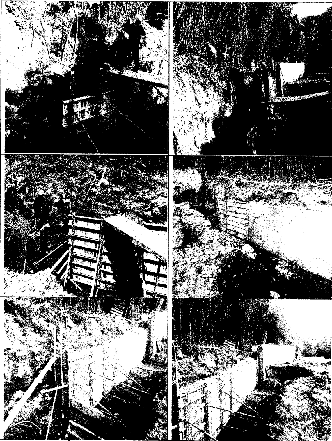
CONCRETO CICLÓPEO (2.500 PSI-17.2MPA) ELEVACION. RESOLUCION IBAL 0636 DE 2016
